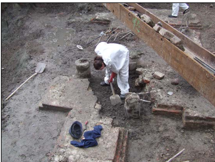
Afbeelding 7. Het handmatig vrijleggen van het muurwerk bij een verstoring door heipalen.
