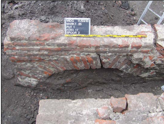
Afbeelding 17. Fundering met spaarboog (Spoor nr. 2).
